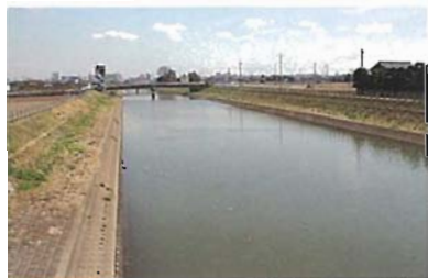
坂川放水路(主水新田)
