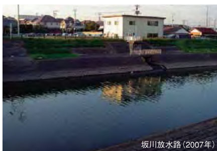
坂川放水路（2007年）
