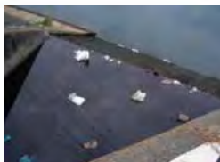
芝崎第二樋管(流山市芝崎地先)
