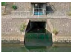
鮎ヶ崎第六樋管(流山市鮎ヶ崎地先)
