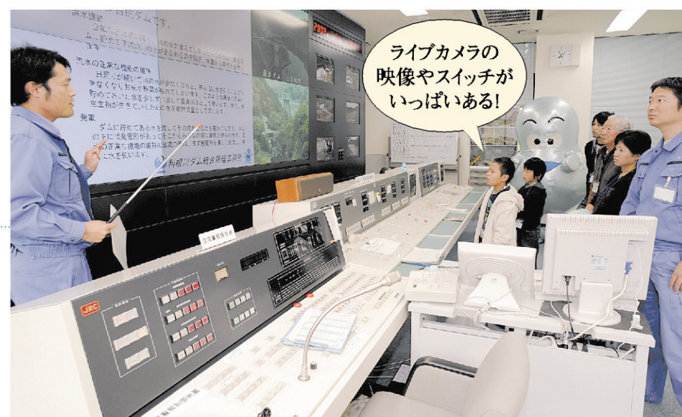
多くの計器が並ぶ操作室。矢木沢ダムと奈良俣ダムのライブカメラの映像も見られる
