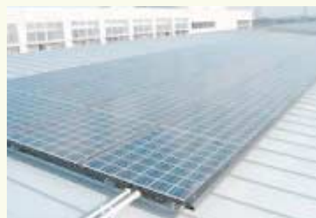
校舎の屋上にある太陽光発電パネル
