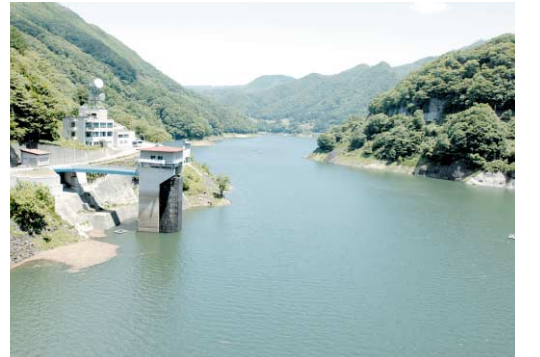
大自然に囲まれた藤原湖。いつもより水量が少ない。左奥の建物が藤原ダム管理所
