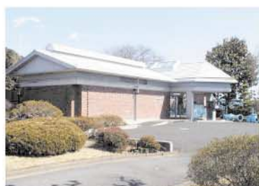
▲建設当時の配水池工事のようす ▶今の剣崎浄水場(高崎市剣崎町1317-1)
