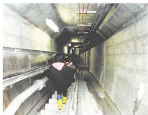
階段でダムの中のいちばん底へ
