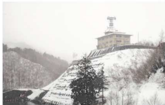
ダムとダム湖を見おろせるところにある管理所
