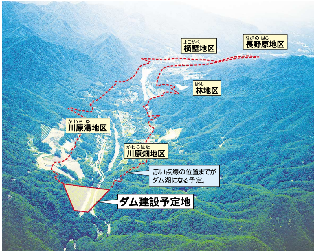
住民が引っ越しをするための土地や新しい道路、鉄道の工事が進むハツ場ダム建設予定地(撮影:2003年6月)
