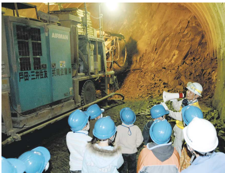
みんな初めて見るトンネル工事のいちばん先の部分！大きな機械で火薬を埋め込むための穴を開ける
