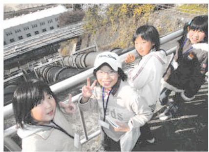
サージタンクから3本の鉄管が発電所へつながる
