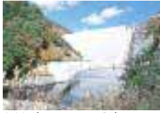
奈良俣ダム(ロックフィル式ダム)
