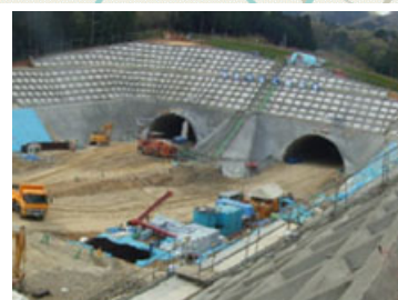
岩瀬トンネル東工事 (桜川市大字松田)
