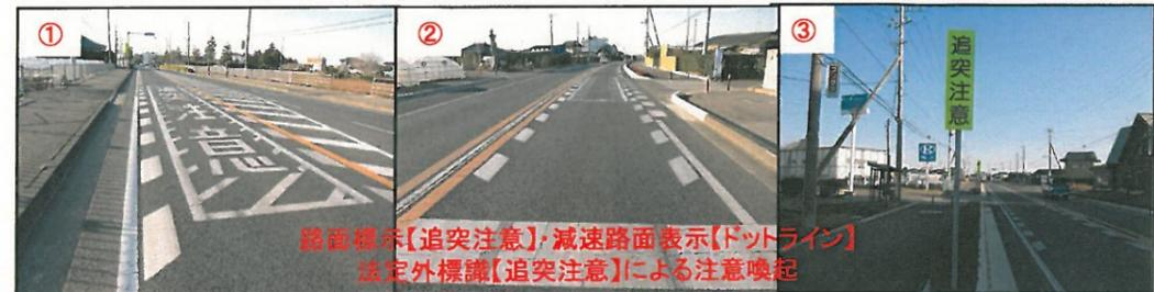
路面標示【追突注意】・減速路面標示【ドットライン】・法定外標識【追突注意】による注意喚起及び速度抑制
