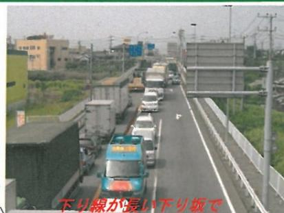
下り線が緩い下り坂でスピードが出やすい! 右折滞留長が短く、後続車を阻害している
