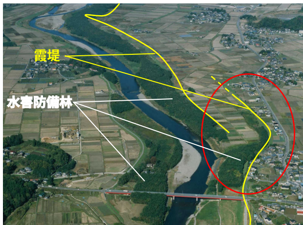
▲富岡橋上流に霞堤の形を残している堤防 (常陸大宮市、旧大宮町) (平成15年11月撮影)
