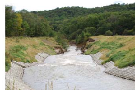
久著路川で実施された床止工
