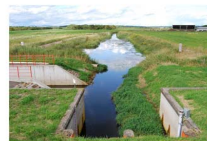
排水路の合流地点に設けられた沈砂地
