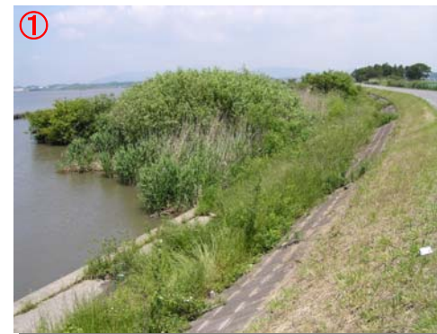
① 浚渫処理ヤード前面の植生帯 (南側より)
