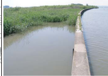
浚渫処理地（矢板護岸） タチヤナギ、エノキ、ヨシ、セイタカアワダチソウ、他
