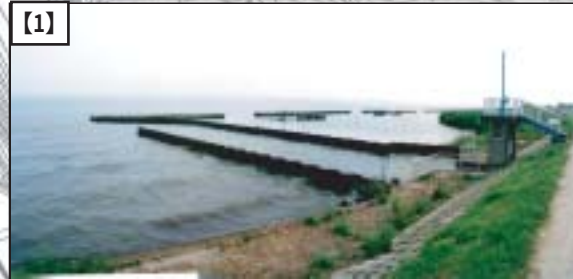
樋門から湖心に向けて流路を固定する鉄板が打ち込まれており、その先から下流側に流れるように粗朶施設が連なる。湖岸にはヨシが群落を形成しており、下流8.4k地点まで、平均幅25m、延長約350mに及ぶ。
