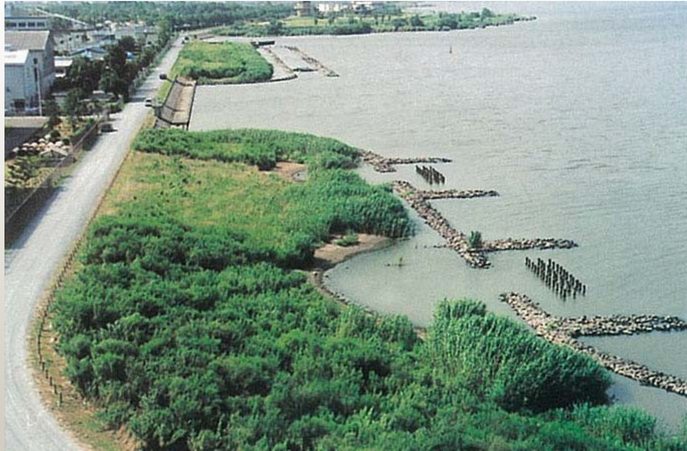
大岩田地区多自然型護岸整備
