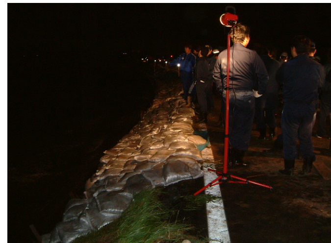
暫定復旧作業完了
