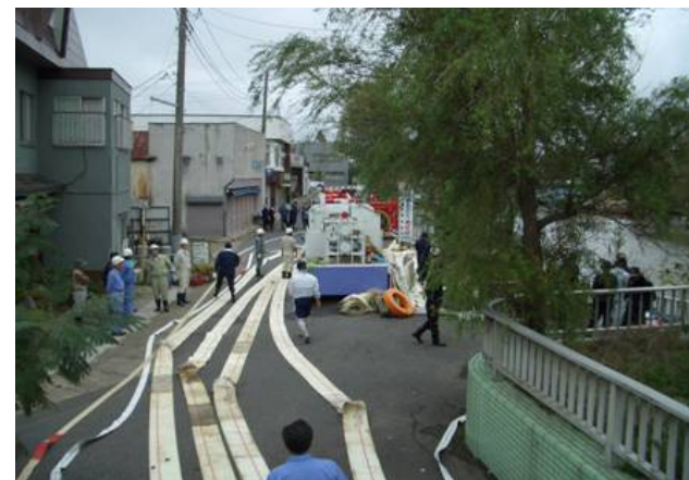
暫定復旧作業状況
