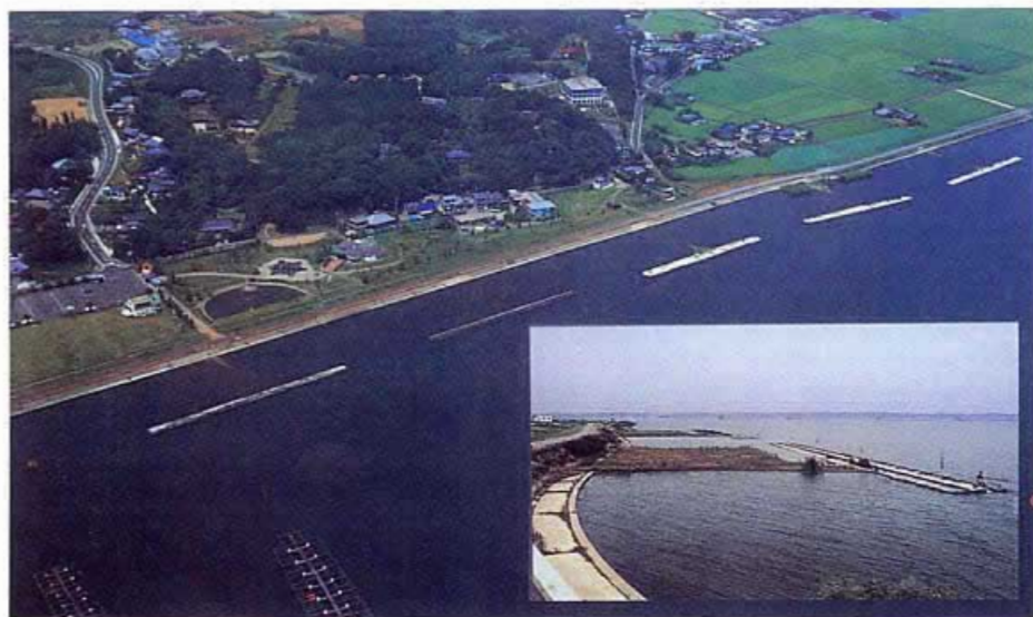
▲田伏地区波浪対策（自然石を使用した離岸堤）
