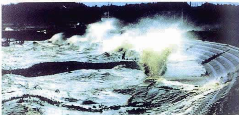
▲北浦・居合地先の越波状況
