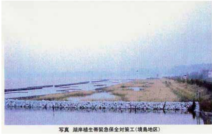
写真 湖岸植生帯緊急保全対策工(境島地区)
