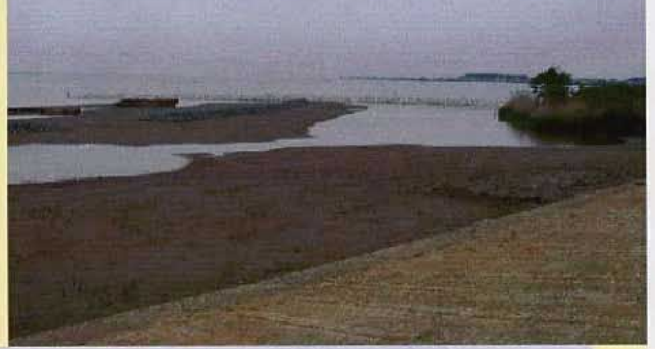
施工直後（平成14年4月）
