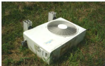
エアコン室外機
