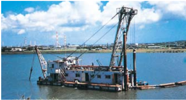
▲常陸川河道浚渫
