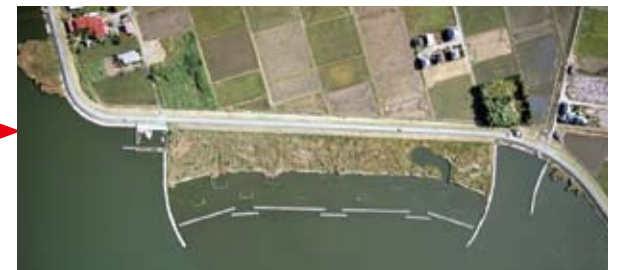
▲整備後／境島 平成20年10月
