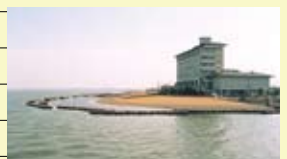
▲耐震対策（港町地区）
