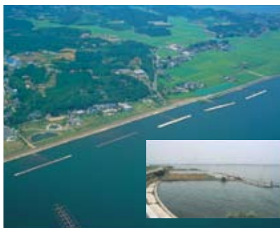
▲田伏地区波浪対策（自然石を使用した離岸堤）
