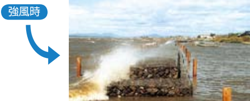
▲五町田地区波浪対策（カゴマットを使用した離岸堤）
