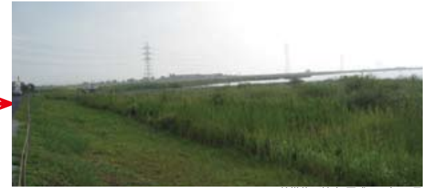
▲整備後／境島 平成20年8月
