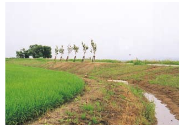
▲大須賀津堤脚水路浄化施設
