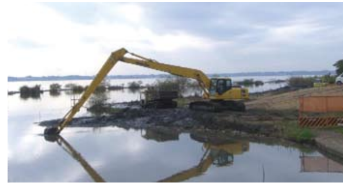
▲土砂撤去作業（川尻川）
