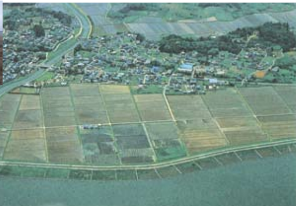
▲植生浄化施設事例（清明川）
