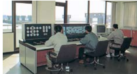
▲常陸川閘門操作室
