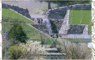
31 山の神沢砂防えん堤 Yamanokamisawa dam 景観に配慮して巨石を張った砂防えん堤 A Sabo dam using large stones in order not to spoil the scenery
