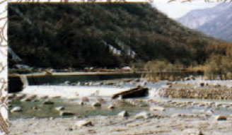
17 広岩床固群 Hiroiwa groundalls 渓流環境、親水性に配慮した代表的な砂防施設 Typical Sabo facilities considering environment
