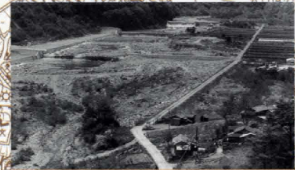
35 シロシシ床固群 Shiroshishi groundalls 釜無開拓地の保全と流下する土砂の安全を図った砂防施設 Sabo facilities to secure reclaimed land and to control sediments
