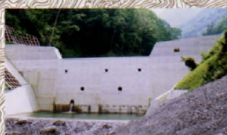
17 本谷第四砂防えん堤 Horitani No. 4 dam 現在、釜無川の上流に位置する砂防えん堤 Sabo dam located at the farthest upper reaches
