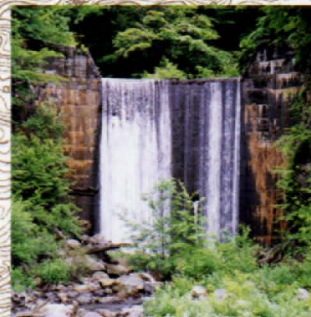
30 黒川砂防えん堤 Kurokawa dam 釜無川上流域を代表するアーチ式の砂防えん堤 Typical arch type sabo dam in the upper reaches
