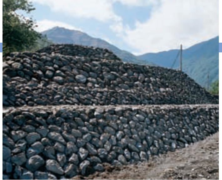
御勅使川の制御のための「A石積み出し」
