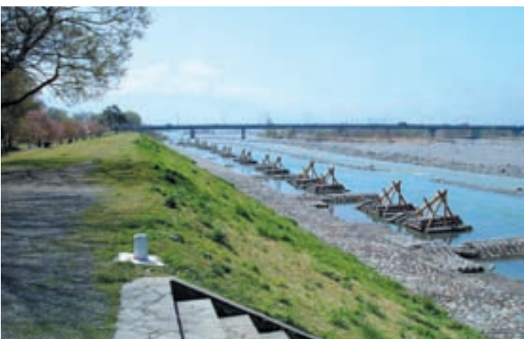
現在は、聖牛とコンクリート練石張も施工されている
