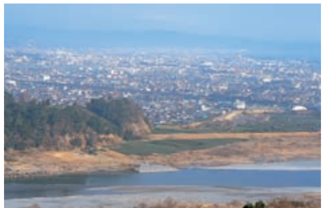
雁堤の北端、岩本山付近には一番出し・二番出し・三番出しが造られている。
