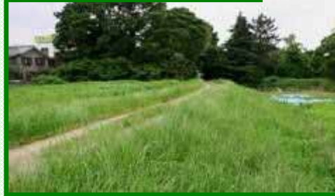
コンクリート護岸(中川)
