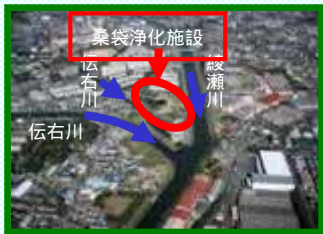
桑袋浄化施設
