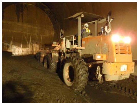
土砂撤去作業
