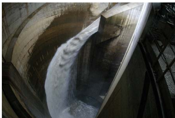
第3立坑流入状況（倉松川の流入）
