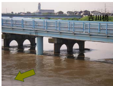
8月29日15時 撮影 中川(左岸)吉川橋付近の状況
