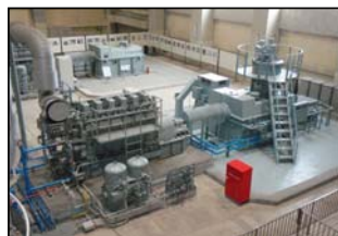
八潮市大字鶴ヶ曽根にある八潮排水機場のポンプ
