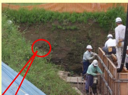
吉川市須賀の工事現場
