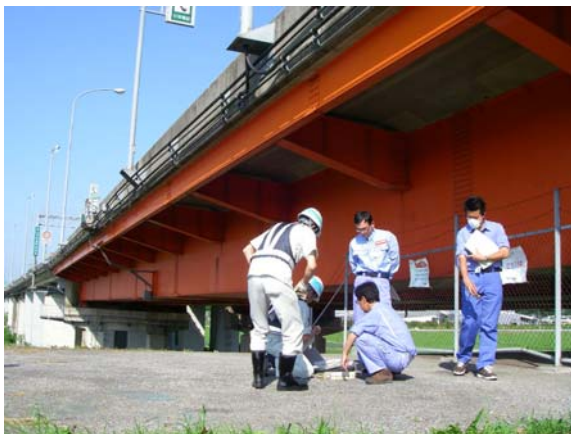
橋梁の管理状況を確認
