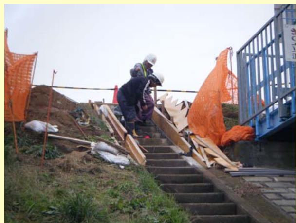
本郷用水樋管脇の階段のすり付け工事を行いました
