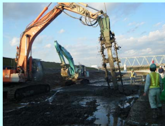
北小岩の防災坂路工事で地盤改良工事を実施しました
