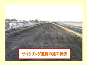
江戸川区内では、江戸川に面して約6kmの内半分にあたる約3kmの堤防拡幅工事を行っています。今回の工事は、堤防を補強し洪水の被害を減らすことが目的ですが、日常的に利用されている皆さんには、次のようなメリットがあります。
