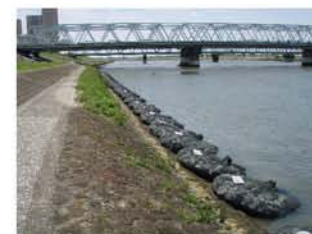
出水期前袋詰根固めによる既設護岸補強
