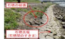
既設石積護岸の破壊状況
