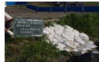
石積破壊部の土のうによる応急処置
