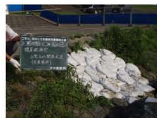
石積破損部の土のうによる応急処置
