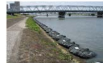
出水期前浚渫根拠による既設護岸補強
