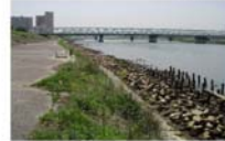
老朽化した護岸（工事箇所全景）
