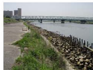
老朽化した護岸(工事箇所全景)
