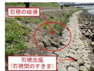
既設石積護岸の破損状況
