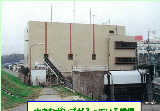
大きなポンプが入っている機場
