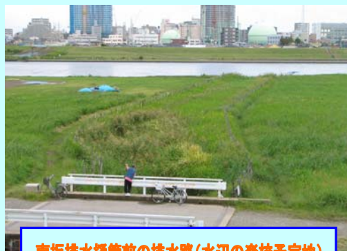
南坂排水樋管前の排水路(水辺の楽校予定地)
