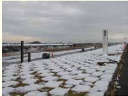
関宿橋下流 右岸 57km
