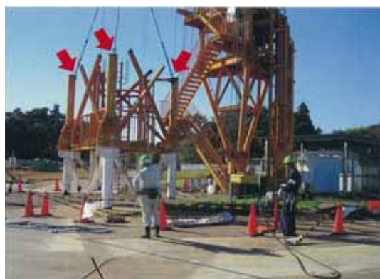
解体作業の状況
