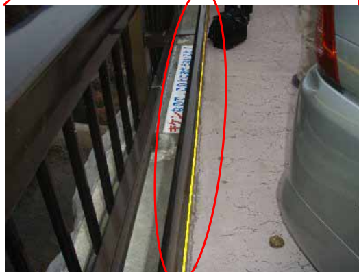
接触した手すり
