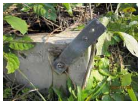
コンクリート片
