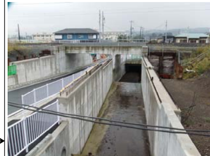
写真② 町道中里線横断BOX(上部)
