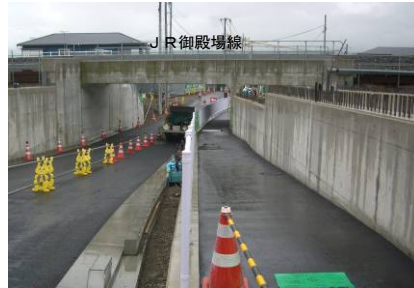
町道中里線(立体)
