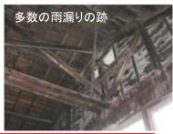
建屋本体の老朽化が著しい。 雨漏りによる漏電の危険や、倒壊の恐れ 有り。
