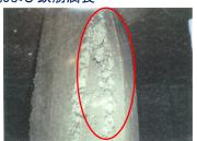
コンクリート強度劣化が著しく、応急処置以上の補修は困難。
