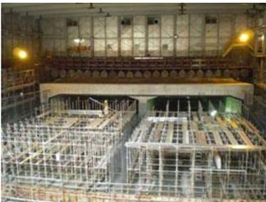
写真③: 防音ハウス内におけるトンネル函体の施工状況
