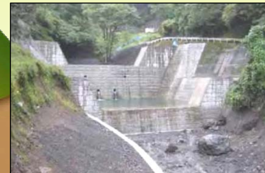
①砂防堰堤の事例 (所ノ沢第四砂防堰堤)
