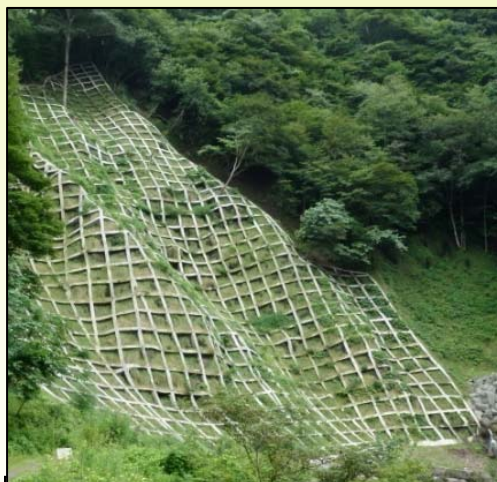
②山腹工の事例 (神流川上流)
