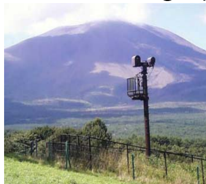
危険箇所の監視設備
