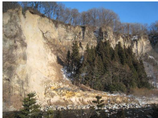
吾妻川で発生した大規模崩壊
