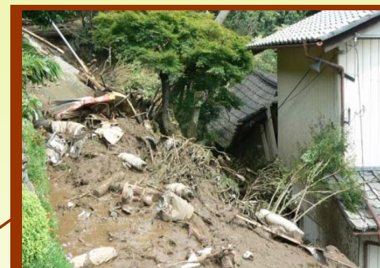
H19年災害土石流で 被災した民家
