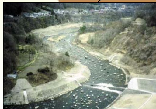
③床固工、護岸工の事例 (大前床固群)
