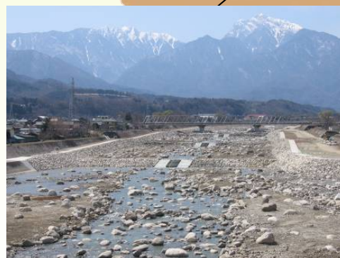
③床固工、護岸工の事例 (大武川床固群)
