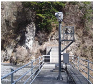
危険箇所の監視設備
