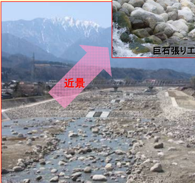
巨石張り工法(大武川床固群)
