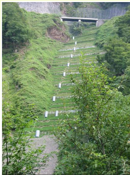
②山腹工の事例 (釜無川上流)
