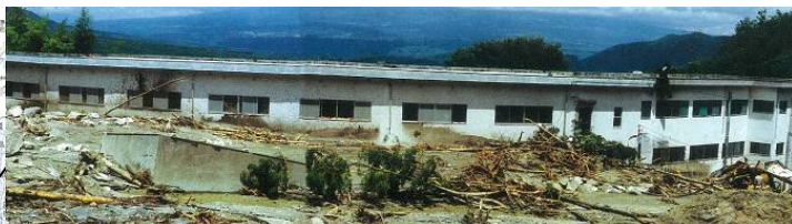
S57年災害 土石流で 被災した 宿泊施設
