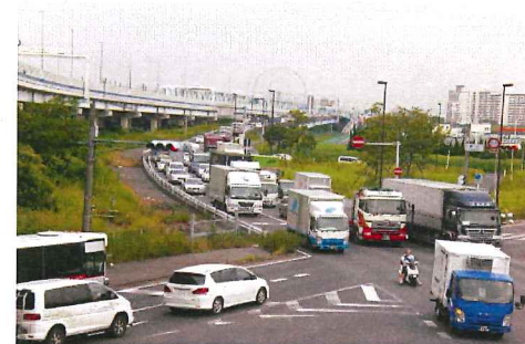
写真一 舞浜交差(H22.7.26撮影 8時台)
