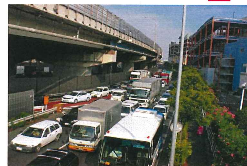
写真一 浜町2丁目交差点 (H22.7.26撮影 7時台)
