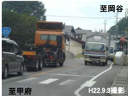
大型車のすれ違いが困難(建倉橋)
