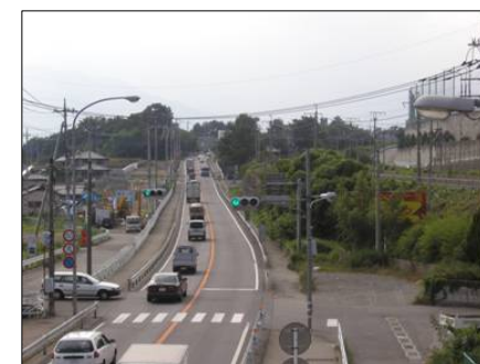
拡幅前の様子
