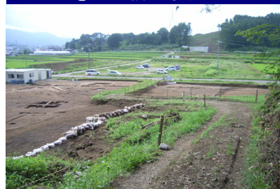
③北川橋工事状況
