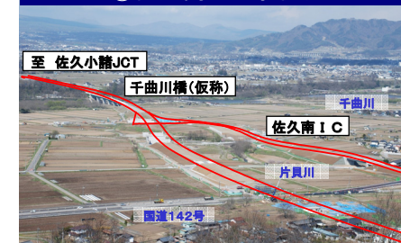
④佐久南IC工事状況
