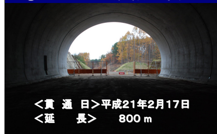
②臼田トンネル(仮称)工事状況
