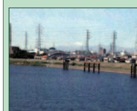
鷹野大橋及び鷹野橋人道橋
