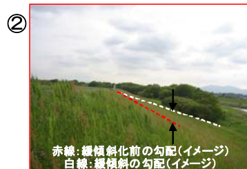
堤防が急勾配となっている
