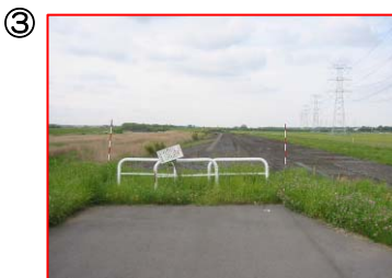
管理用通路の連続性なし
